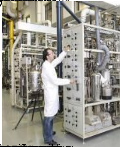
Εικόνα 2: Πυκνωτήριες μονάδες παραγωγής αερίου σύνθεσης (SYNGLAS 0NH)
